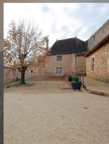
Aménagement extérieur avec le traitement des façades à la chaux naturelle, finition dite à pierres devinées, un revêtement stabilisé en gravillon ton clair, et une rampe extérieure en béton désactivé
