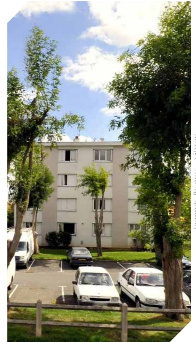
Logements - Résidence - La Blaiserie
